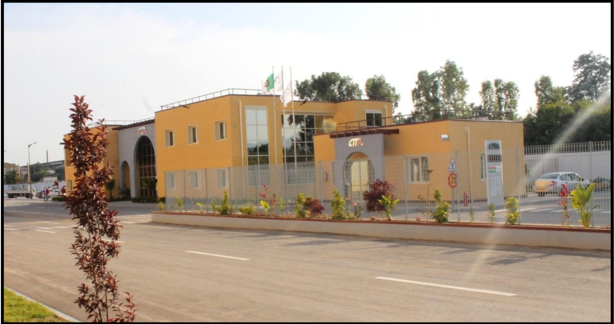
Figure I.1 : Accueil de l'usine CITAL à Annaba [1]
