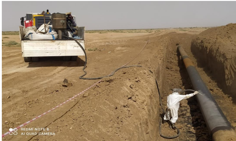
Figure 1.11 : Opération de sablage de la pipe en exploitation[10]
