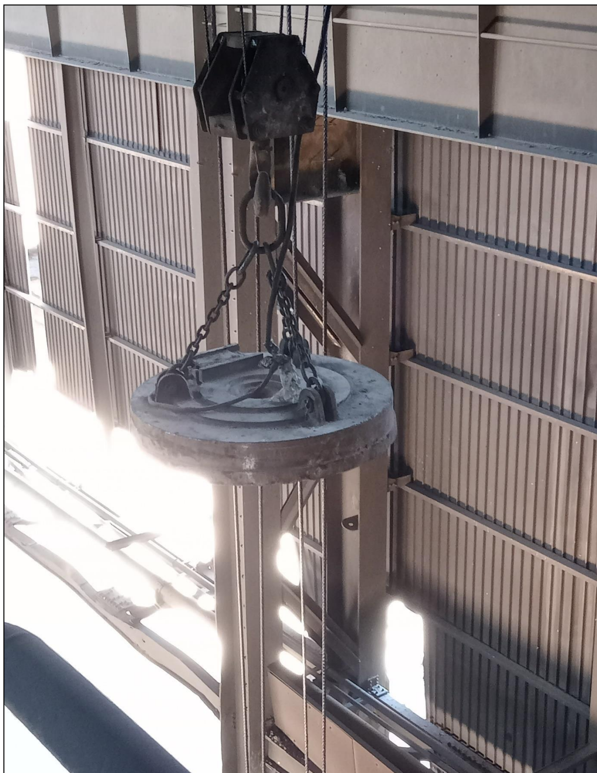
Figure III.1 - levage auxiliaire du pont 704
