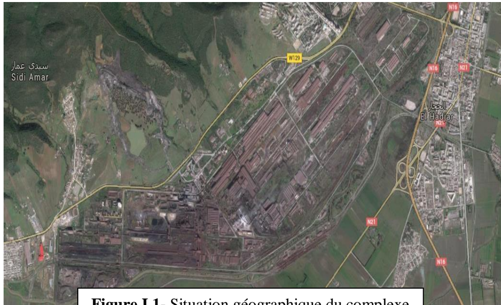
Figure I.1- Situation géographique du complexe
