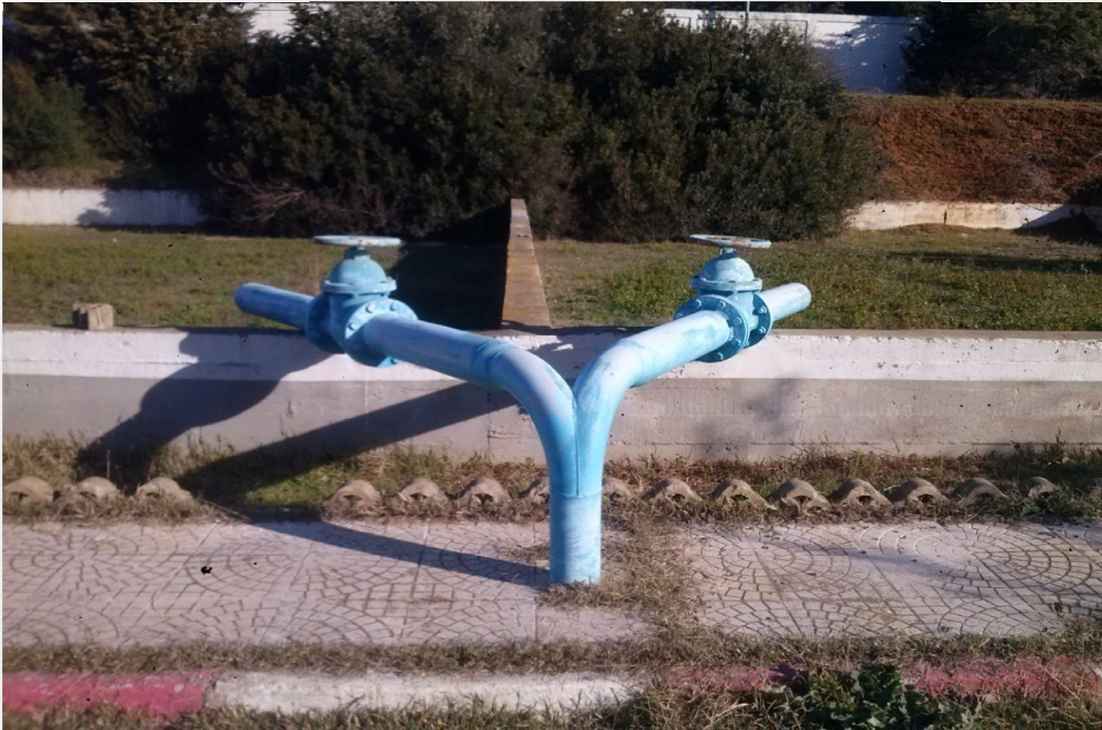
Photographie n°13: Lits de séchage
