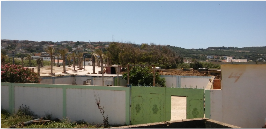
Photographie n°2: Station de relevage El MORDJANE.
