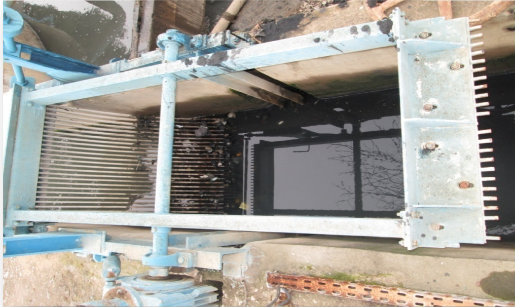
Photographie n°6: Dé grilleur fin mécanisé.
