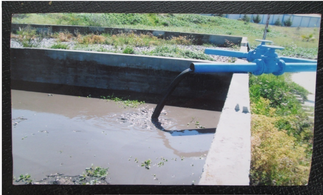
Photographie n°11: Extraction des boues.
