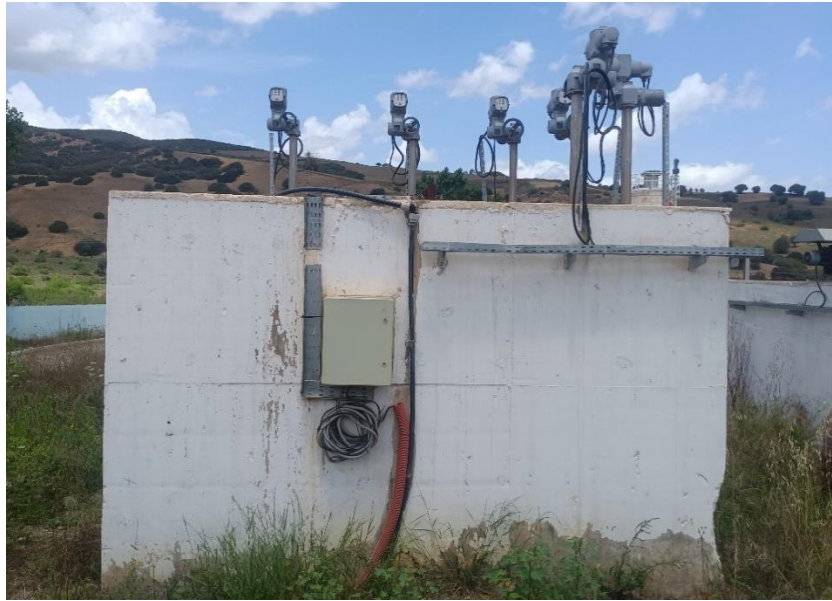
Figure III.7 : Bâche de floculation 2 ème chaine de production.
