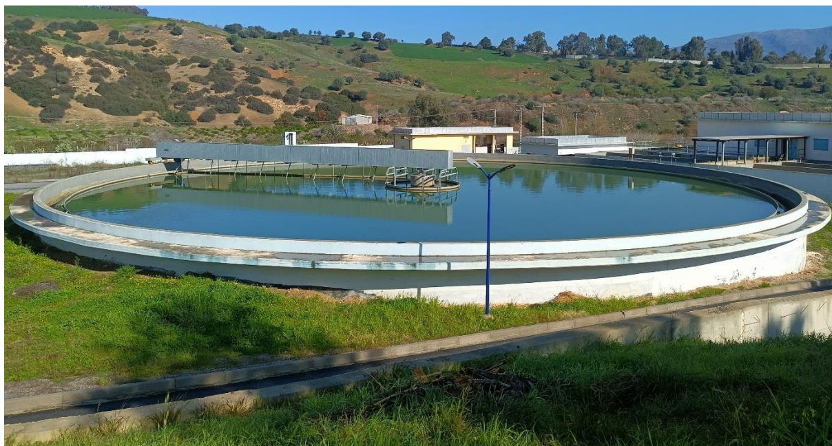
Figure III.10 : Décanteur 2 ème chaine de production.
