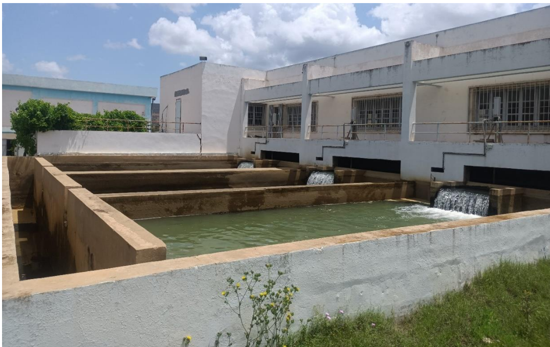
Figure III.11 : Modules de 3 filtres ouverts à sable 1 ère chaine de production.
