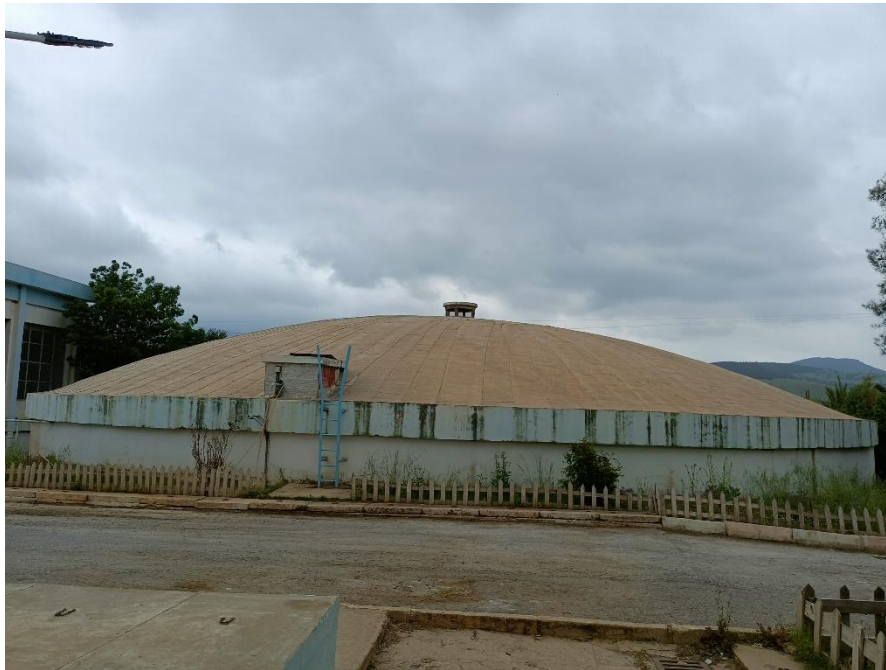
Figure III.15 : Réservoir de stockage 1 ère chaine de production.
