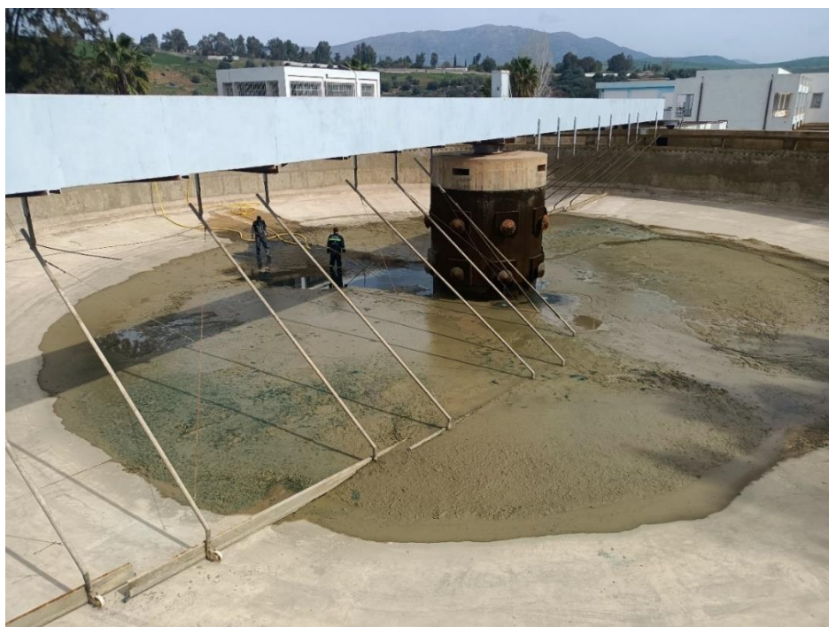
Figure III.17 : Evacuation des boues du fond de décanteur manuellement avec des pompes mobiles 1 ère chaine de production.
