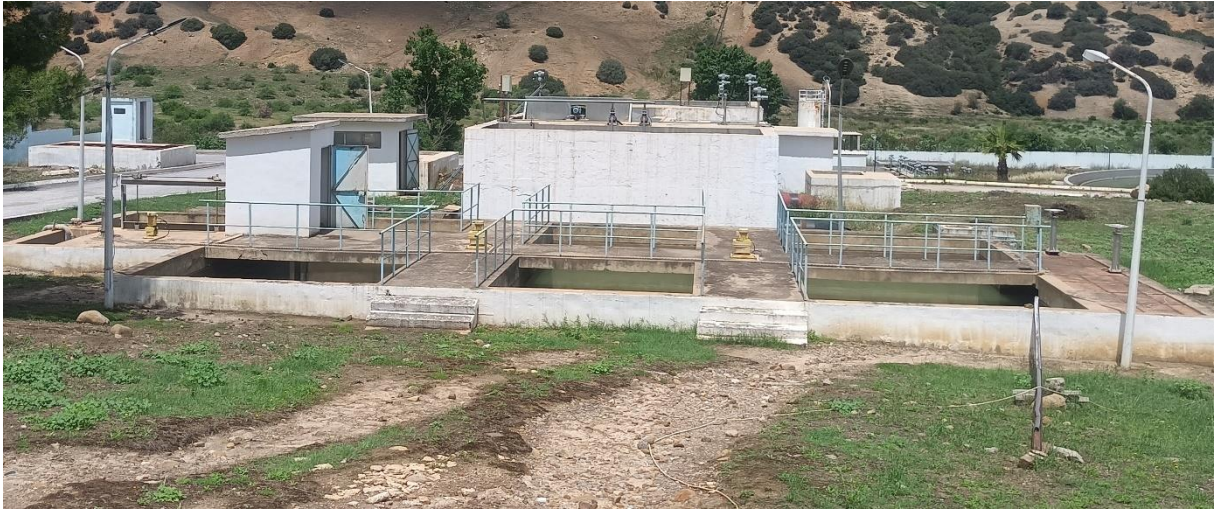
Figure III.2 : Bassin de mélange 1 ère chaîne de production
