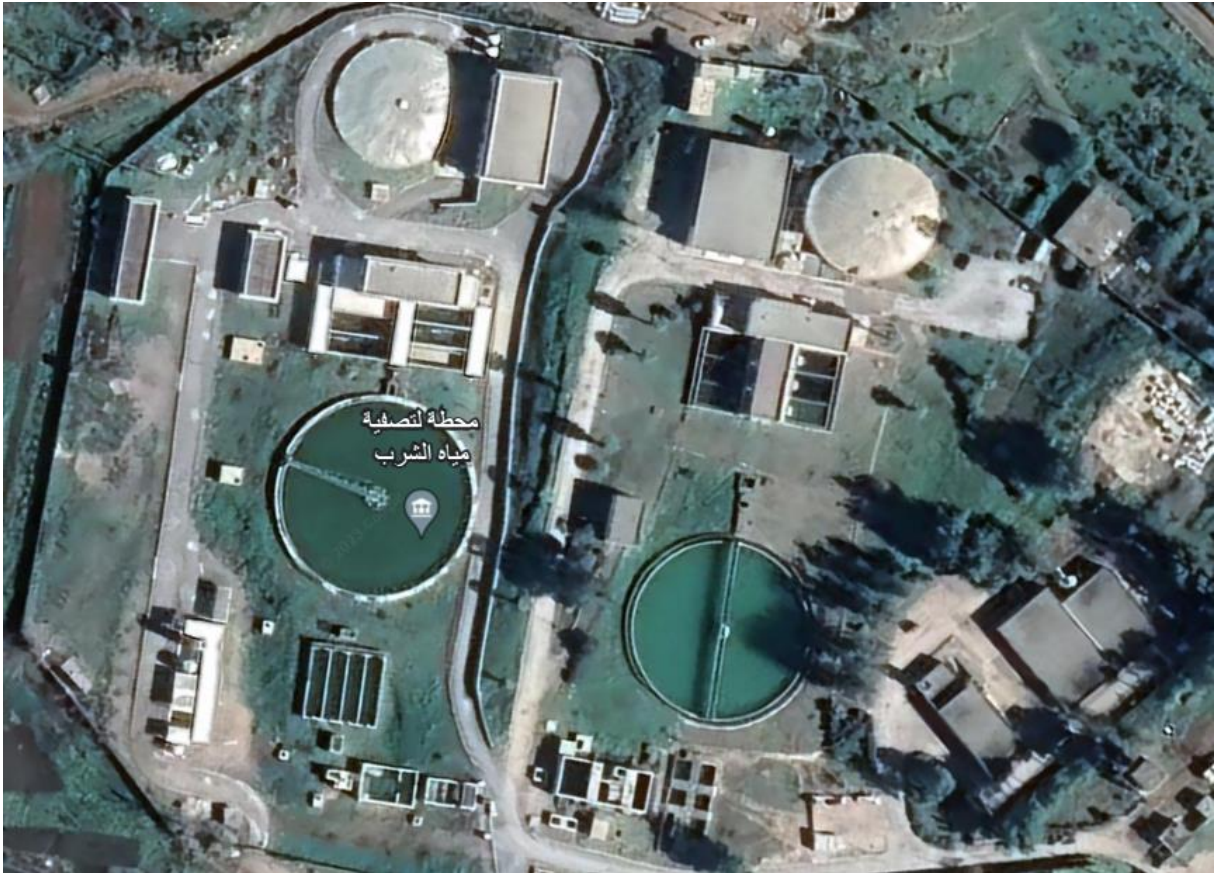
Figure.II.1 : Station de traitement eaux potables de Hammam Debaghe-Guelma (Google earth).
