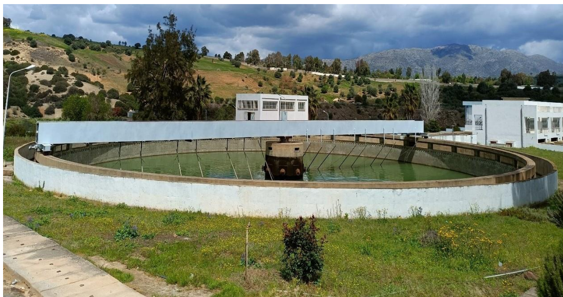
Figure III.9 : Décanteur 1 ère chaine de production.
