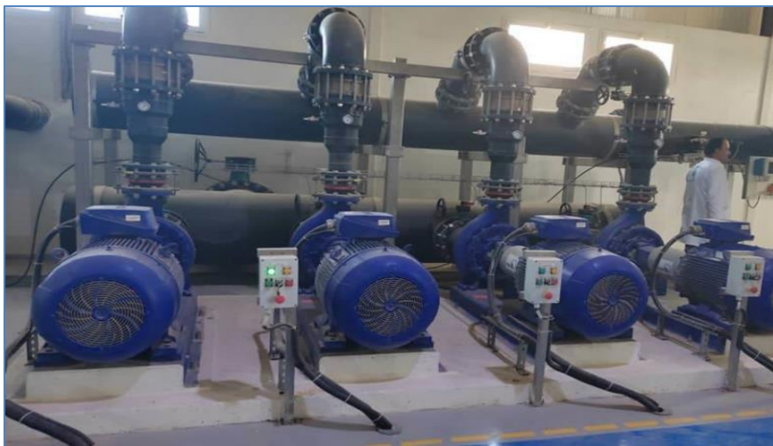
Figure II.10 : Pompes d'alimentation base pression (BP).
