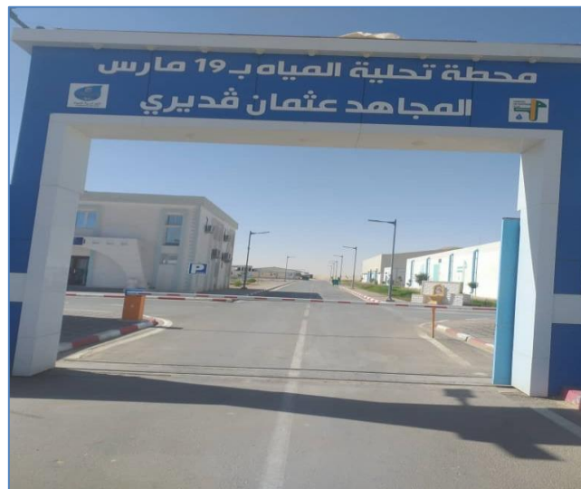
Figure II.1 : La station de déminéralisation 19 mars
