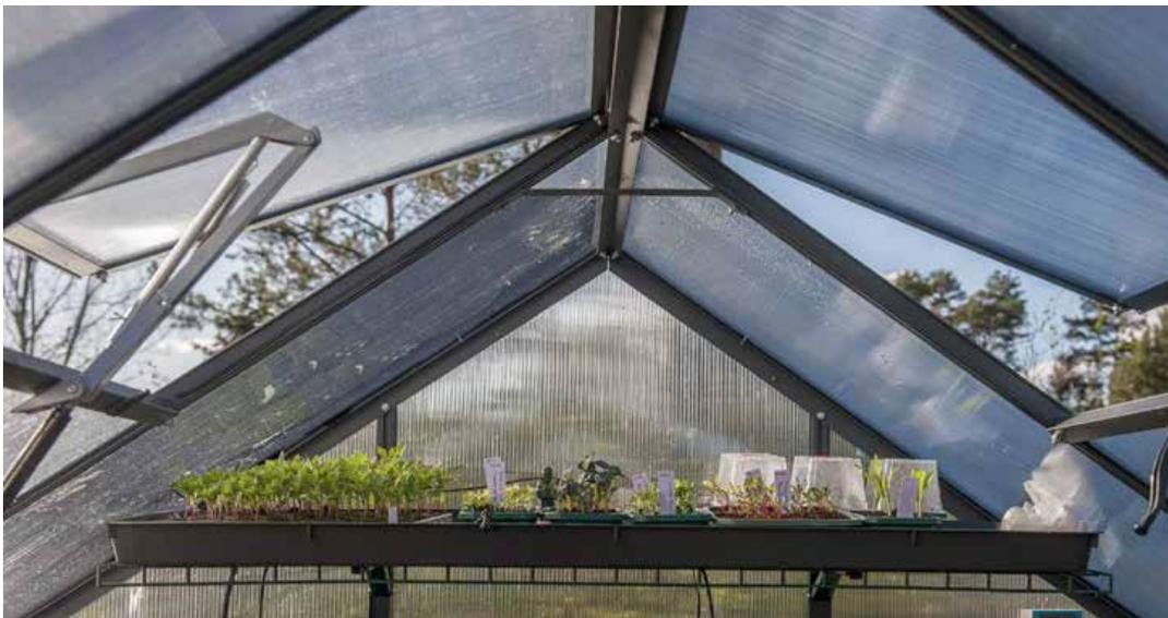
Figure 2.9 l'aération par toit des serres agricole [17]
