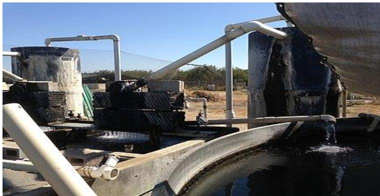
**Figure 3:** Un biofiltre et un dégazeur de  $\text{CO}_2$  sur un système d'aquaculture à recirculation extérieur utilisé pour cultiver l'achigan à grande bouche.
