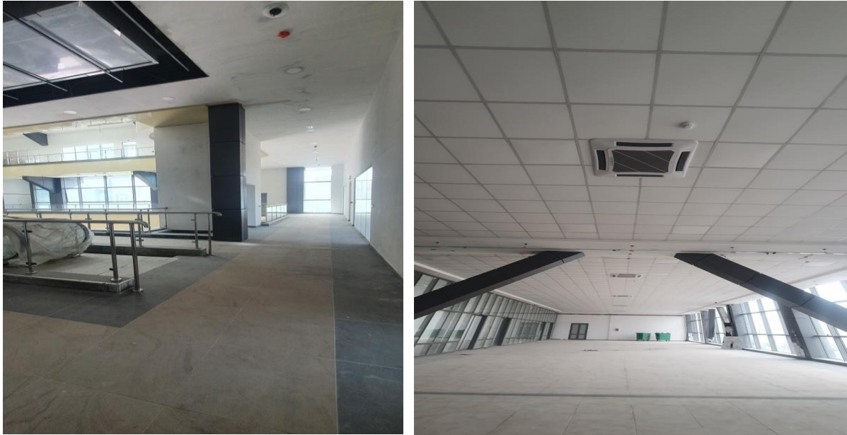
Figure.II.3.Vue intérieure de la gare maritime Annaba.
