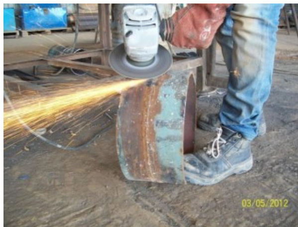
Figure 80 : Limage du cordon de soudure.
