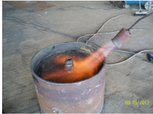
Figure 79 : Traitement d'un cordon de soudure par chauffage.
