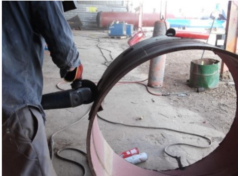
Figure 81 : Enlèvement de la matière du cordon de soudure.
