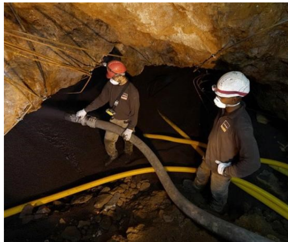
B/ Application des coulis dans les travaux souterrains
