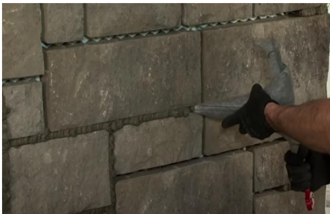
C/ Remplissage des joints
