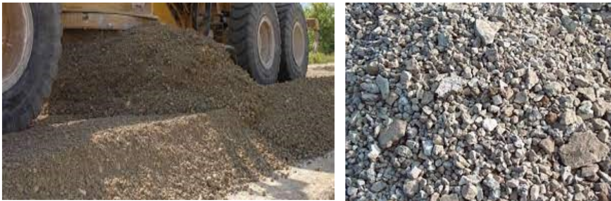
Figure I.41. Utilisation du laitier cristallise en remblai
