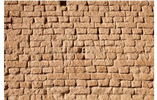
Figure I.13. Mur de briques d'Adobe
