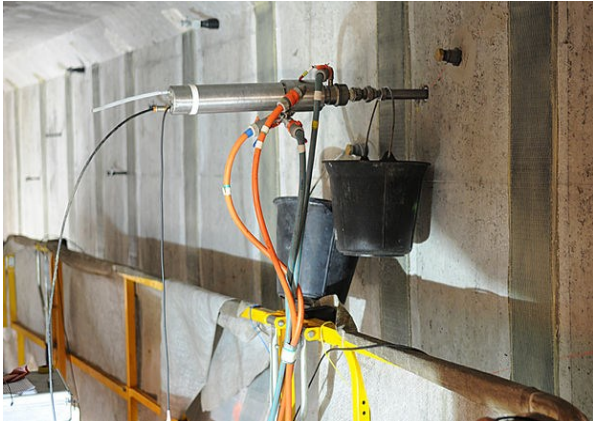
A/ Injection des gaines du béton précontraint
