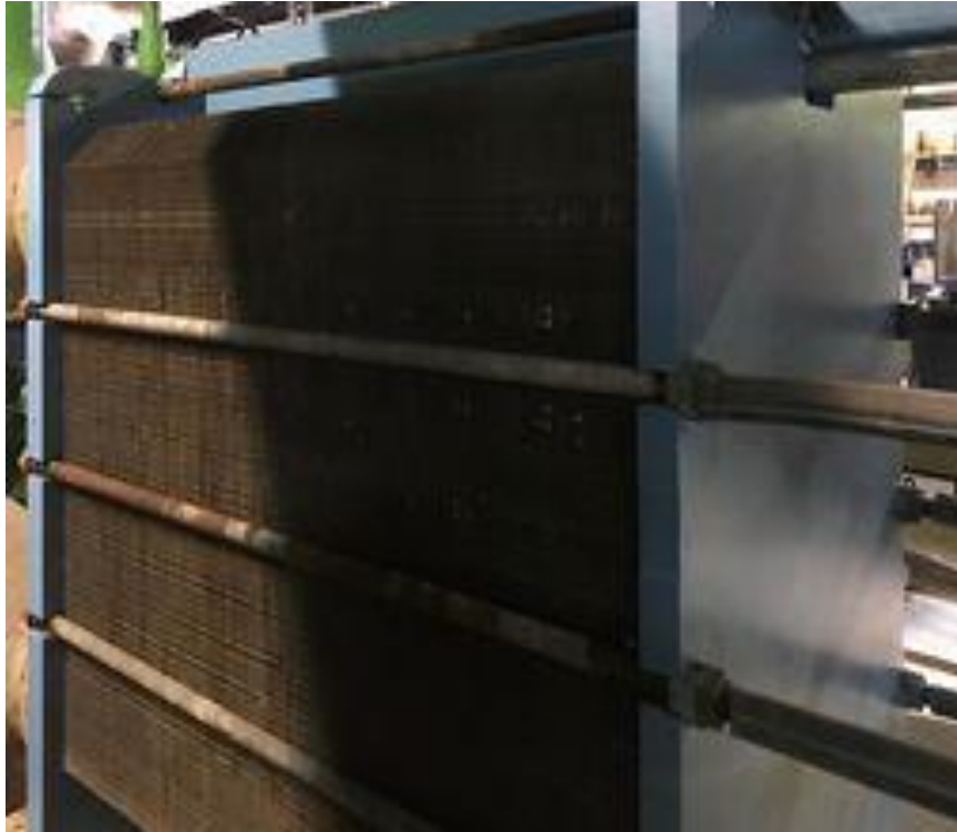
Figure I.3 : Echangeur de chaleur à plaques.
