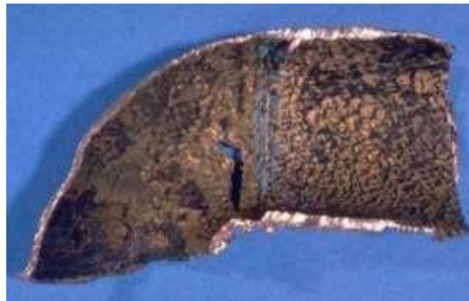
Figure I-22 : La corrosion érosion
