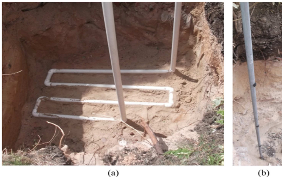
Figure 2.13 : Photos du montage (configuration) expérimental (a) échangeur de chaleur en PVC et (b) instrument de mesure du profil de température du sol [39].
