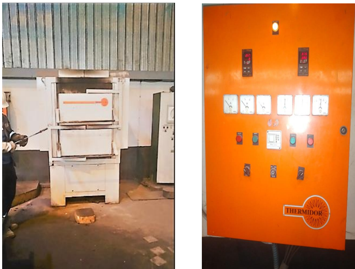
Figure : III.3. Traitement d'amélioration (revenu)
