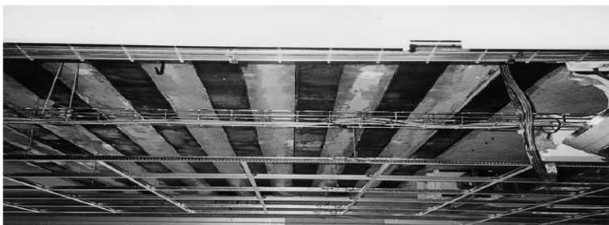
Figure 2.30: Exemple de renforcement d'une dalle de plancher (Luyckx J.,1999)
