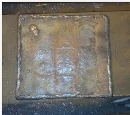
Figure IV-6 : pièce fini après rechargement
