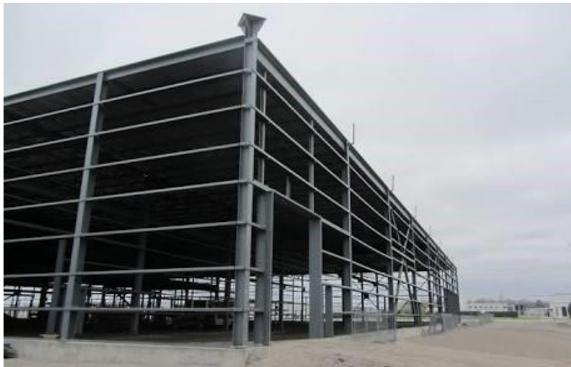
Figure 44 : Façade avec des lisses
