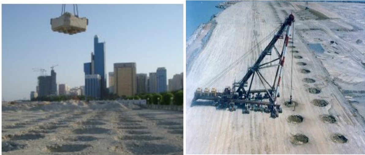
Figure II.15. Points d'impact d'un compactage dynamique
