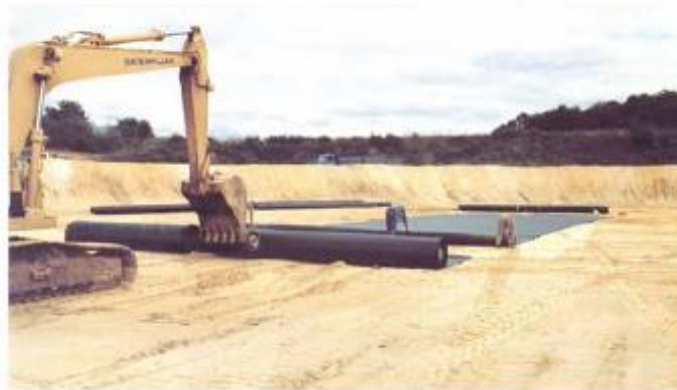
Figure II.3.1-Etanchéité périphérique vue d'un chantier en cours de pompage
