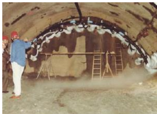
Figures II.13. Traitement par congélation à Vienne sous bâtiment pour tunnel de métro
