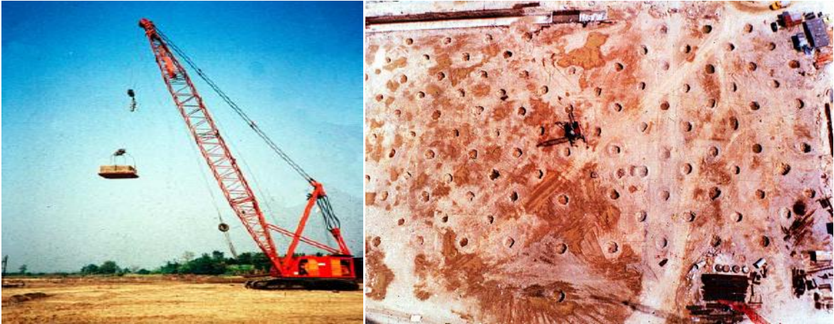
Figure II.14. Engin de compactage (150kN tombant en chute libre de 25m) Aspect d'un chantier avant comblement des cratères
