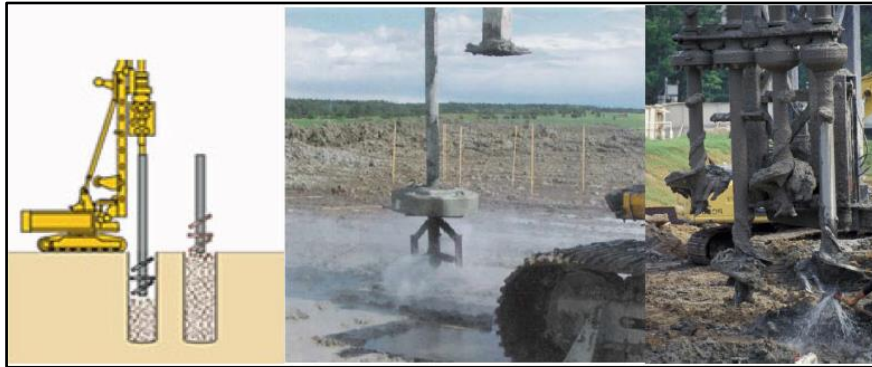
Figure II.11. Principe de réalisation des colonnes ballastées
