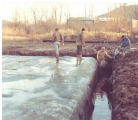
Figure II.3.2- Etanchéité périphérique vue d'un chantier en cours de pompage
