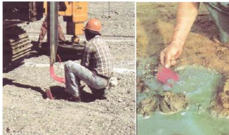
Figure II.7.2 Mise en place et fonctionnement du drain
