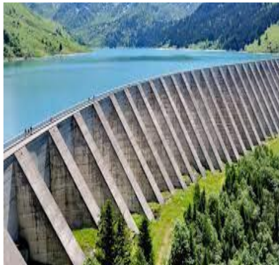
Figure 7 : Barrage à contreforts (Schleiss and Pougatsch, 2011)
