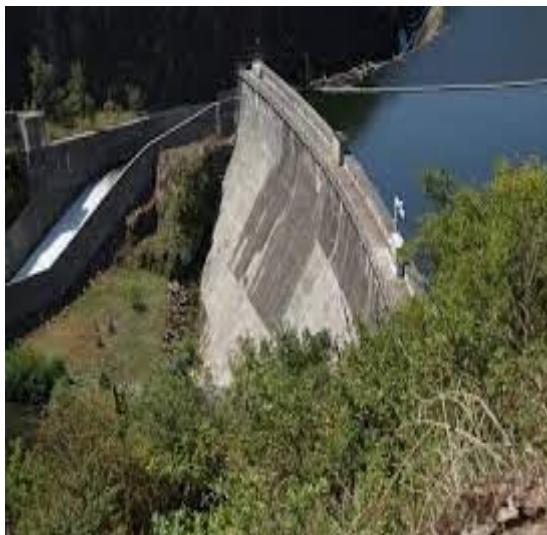
Figure 6 : Barrage poids (Schleiss and Pougatsch, 2011)
