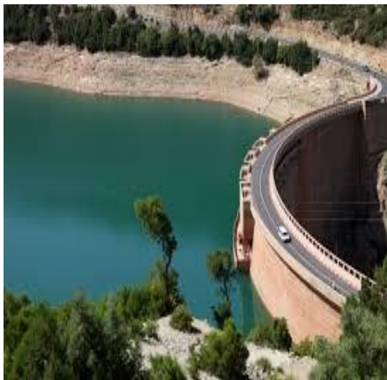
Figure 8 : Barrage voûte (Schleiss and Pougatsch, 2011)
