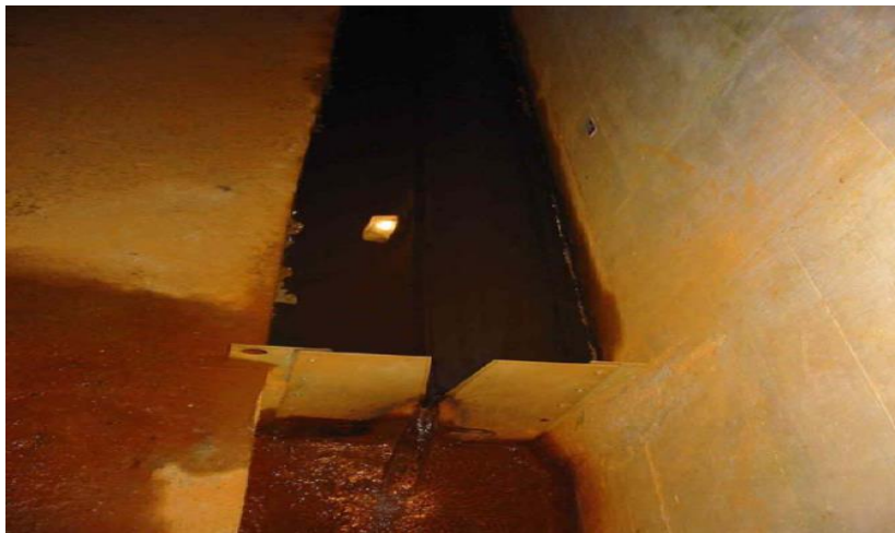
Figure 73 : Mesure du débit par déversoir triangulaire.
