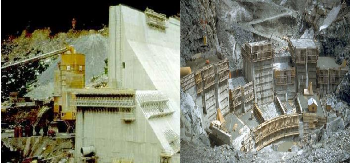
Figure 3 : Construction du barrage par plots (Schleiss and Pougatsch, 2011)
