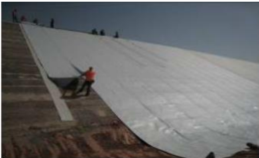
Figure 38 : Pose de géomembranes (Barrage de Sar Cheshmeh, Iran) (Lehbab, 2019)
