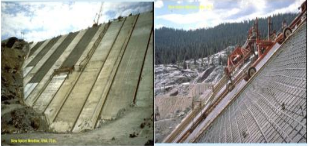
Figure 37 : Masque en béton armé (barrage New Spicer Meadow, USA) (Lehbab, 2019)
