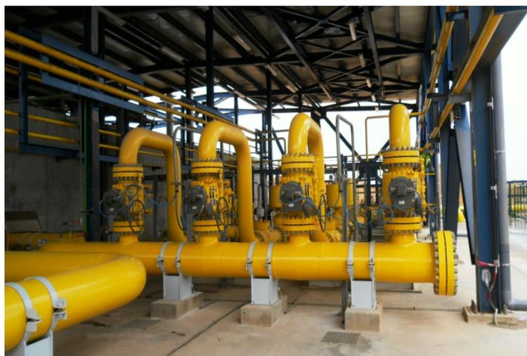
**Figure (14) : Poste de filtrage et de détente de la gaze ERM.**
