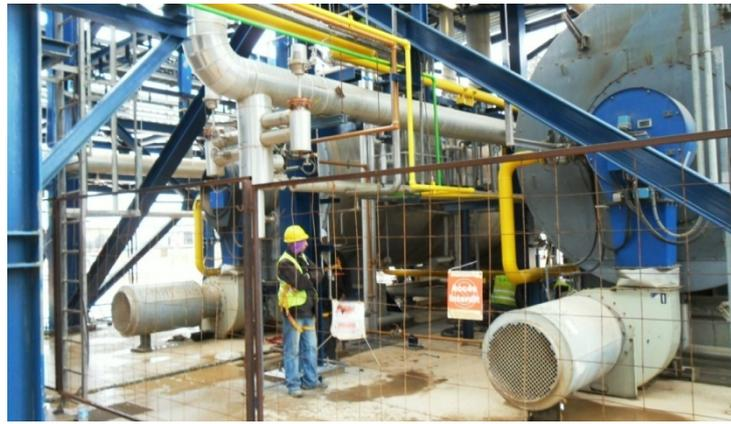
**Figure (8) : Chaudière auxiliaire.**
