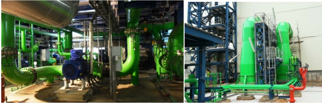
Fig.2.24 Système de refroidissement fermé.
