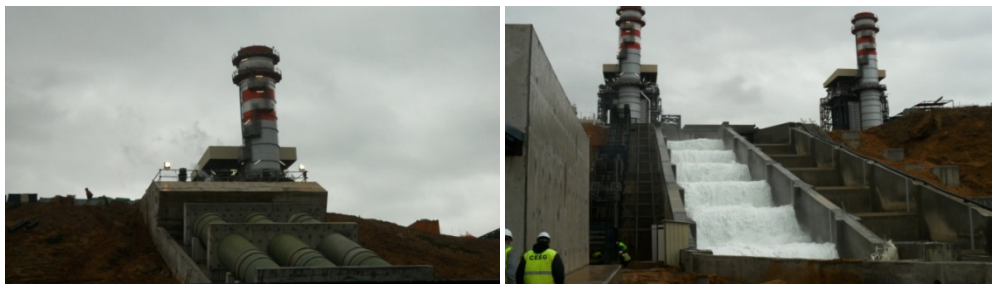
Fig.2.25 Système de refroidissement ouvert.
