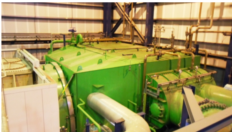
Fig.2.14 Condenseur de vapeur.
