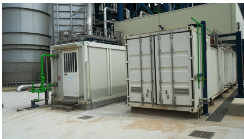
Fig.2.22 Stations dosage et échantillonnage.
