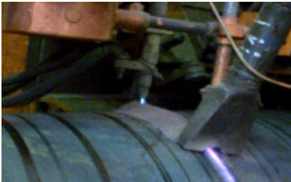
Figure III.3 : soudage extérieur du tube par le procédé SAW dans ALFAPIE
