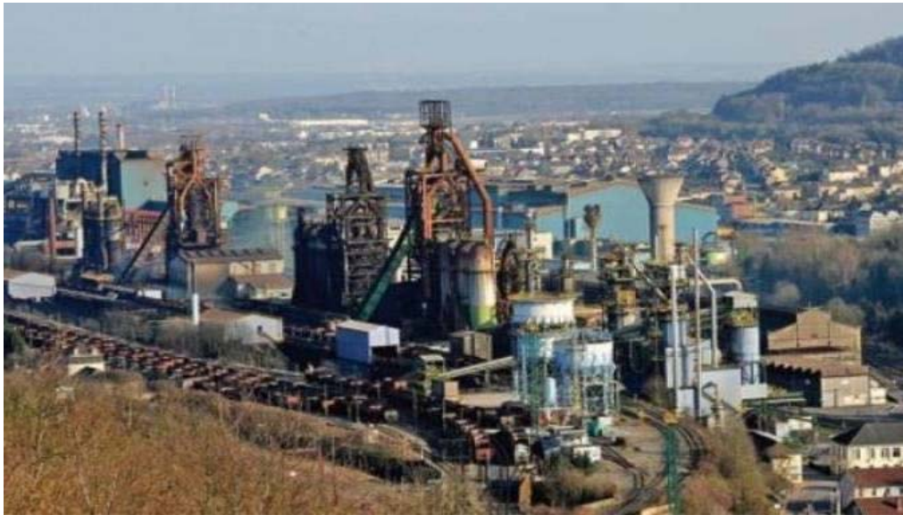
Figure I.1 : Vue générale sur complexe sidérurgique d'El-Hadjar (1) .
