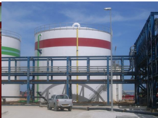
Fig.1.19. Bac de stockage eau PCI.
