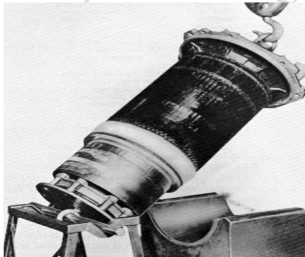
Figure II-24. L'induit.
