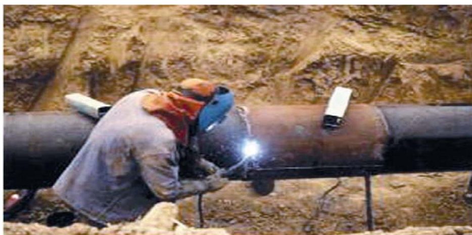
Figure V. 4 : Opération de soudage des demi-coquilles.
