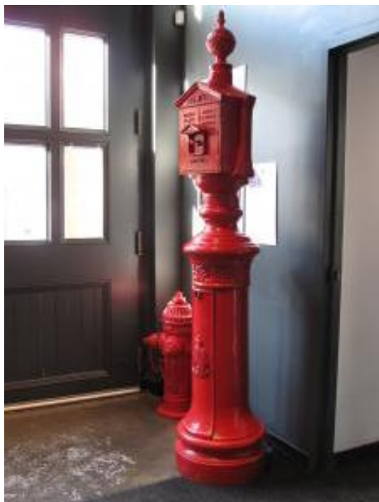
Fig 1.1 boîte d'appel incendie
