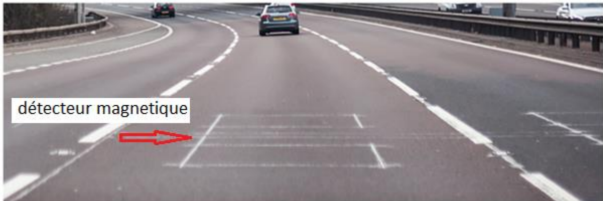
Fig 2.10 Détecteur à boucles inductives
