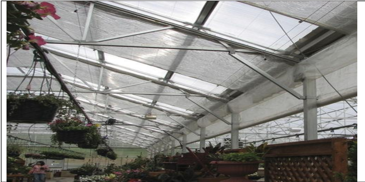
Figure I.9 : Rideaux utilisés dans les serres pour réduire la lumière du soleil [10].
