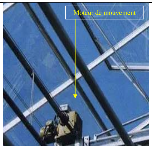
Figure I.7 : Ventilation par des fenêtres automatiques [6].
