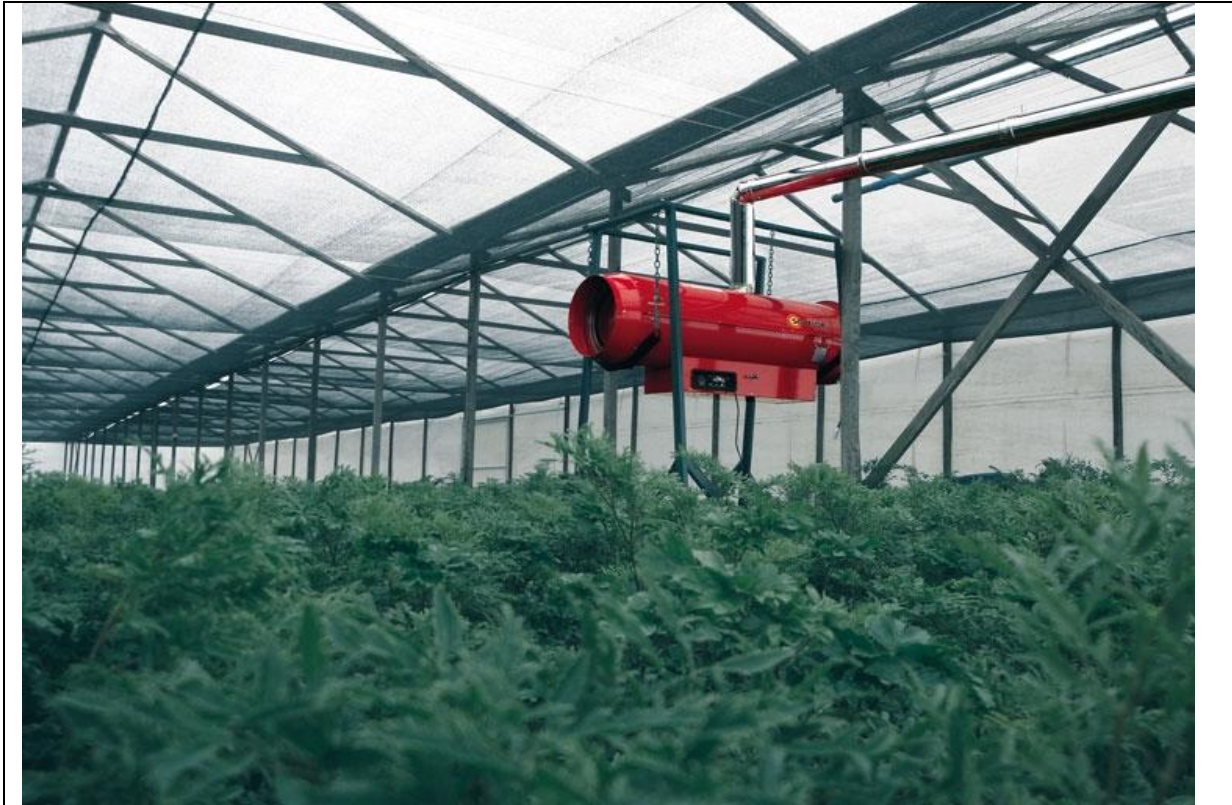
Figure I.8 : Exemple d'appareil de chauffage utilisé dans les serres [6].
