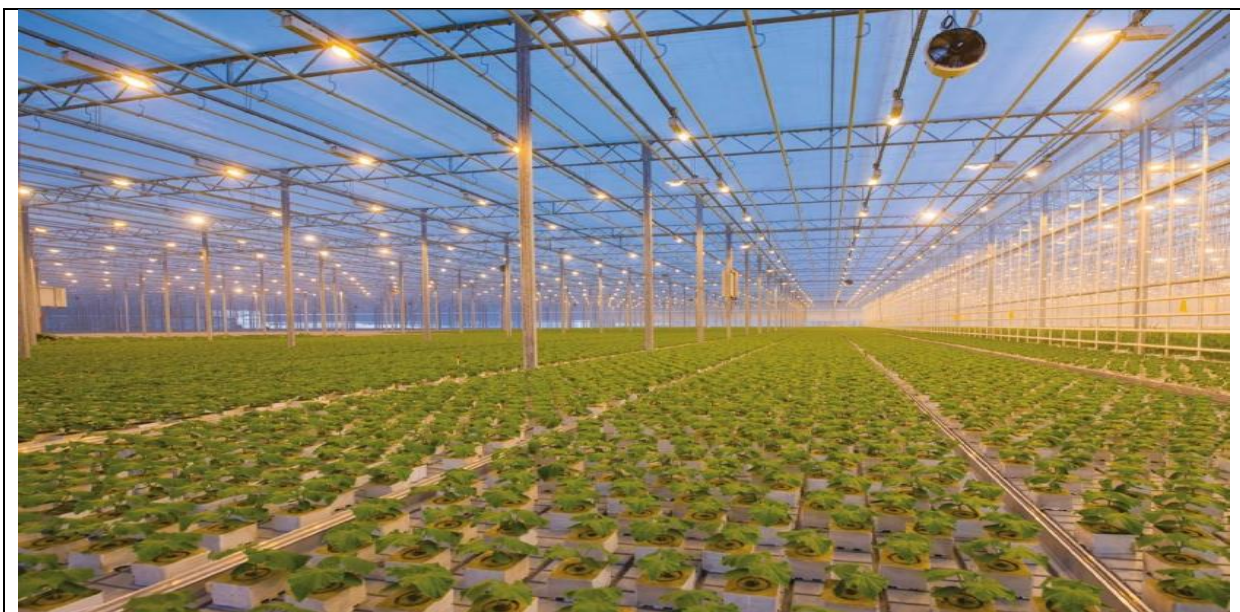
Figure I.12 : Éclairage SHP dans une serre agricole [15]
