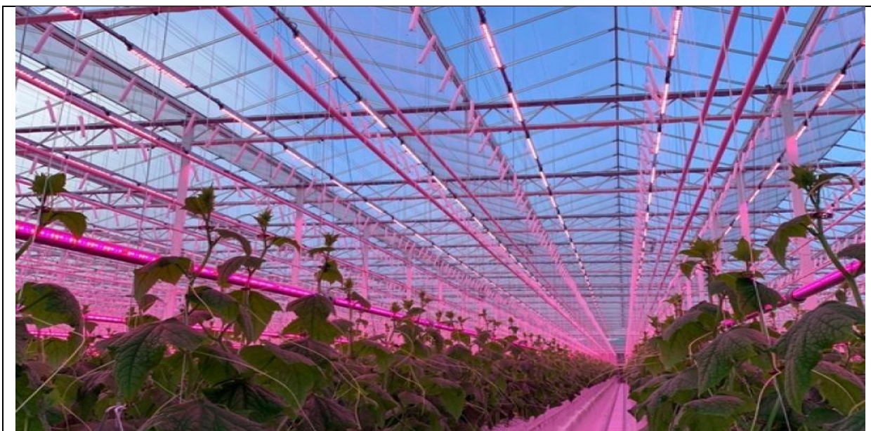
Figure I.11 : Éclairage LED dans une serre agricole [13].
