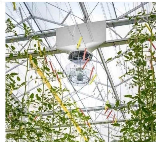
Figure I.6 : Ventilation par extracteur d'air [6].
