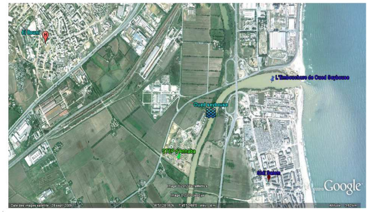
Fig.9 : Station d'épuration d'Annaba.
