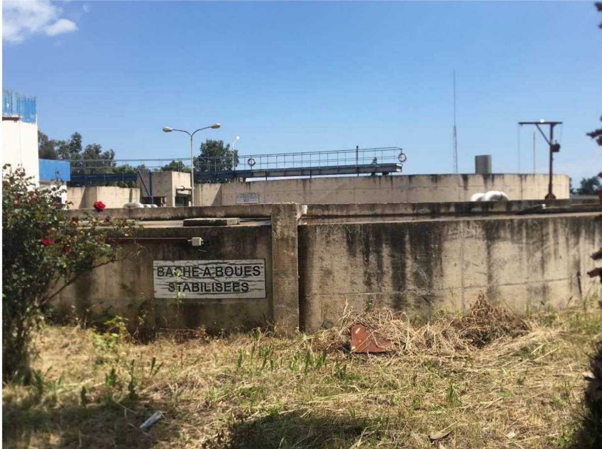
Photographie 10 : Bâche a boues stabilisées.
