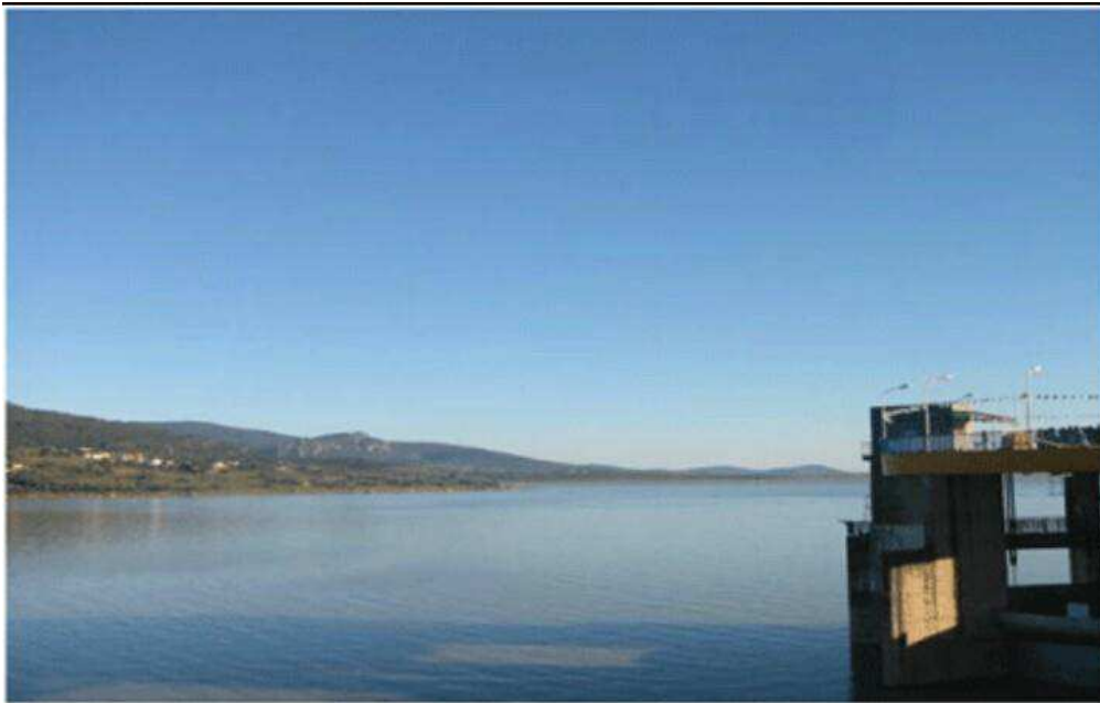
Photo 3: Barrage de CHAFFIA
