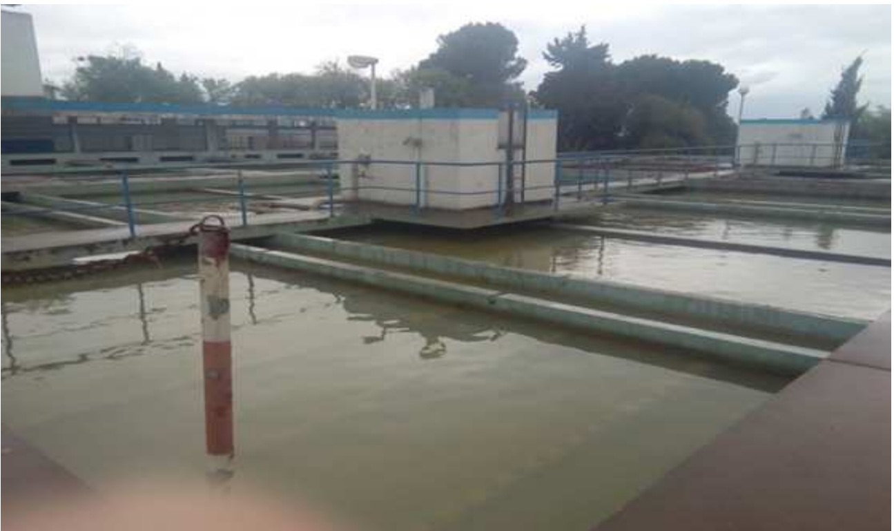
photo.9: Vue générale d'un décanteur PULSATOR
