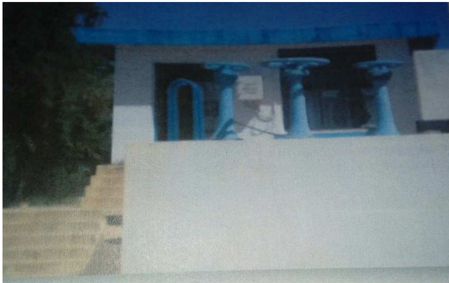
Photo 8: Poste de pré chloration «CHAIBA»
