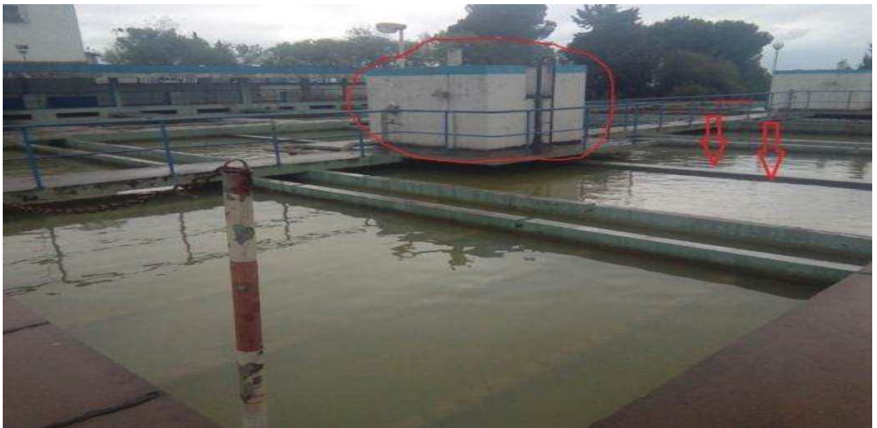
Photo 6 : Ouvrage de décantation
