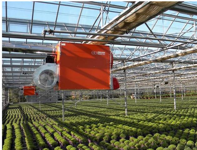
**Figure III.6 :** Le générateur d'air chaud.
