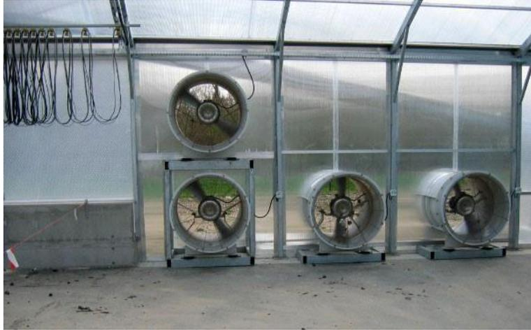
**Figure III.16 :** Ventilation Forcée.
