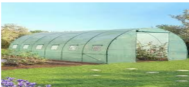
Figure III.9 : une serre agricole
