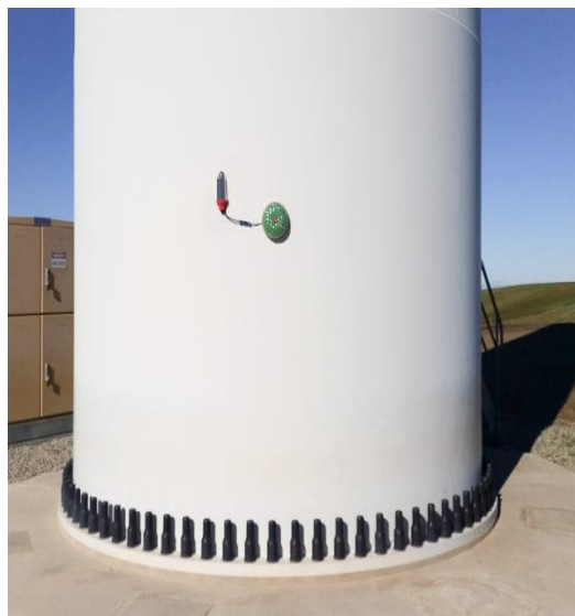
Figure 8: Moniteur Ping monté magnétiquement sur une tour de turbine [17].
