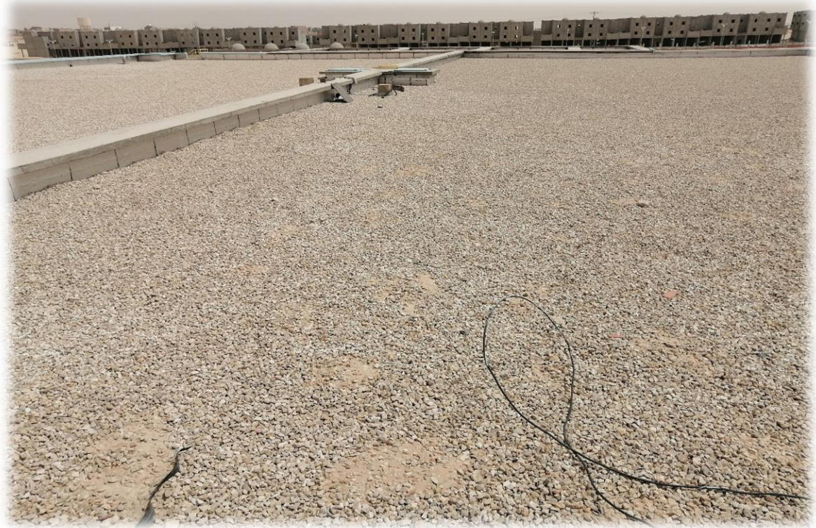
Figure III.10: Réservoir de stockage.
