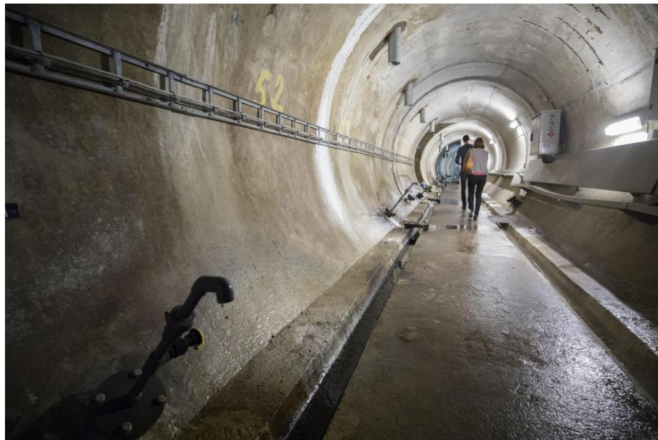
Figure 1 : Les drains.
