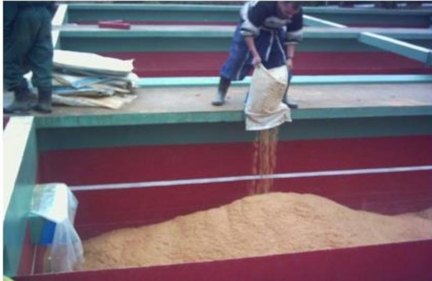
**Figure 11 :** mise en place de la couche du sable.
