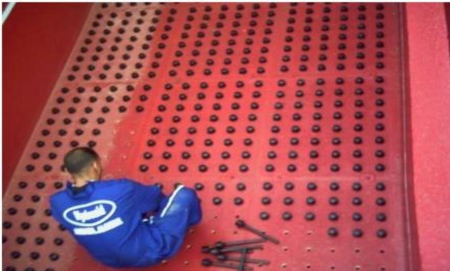
**Figure 10** : plancher de buslure d'un filtre.
