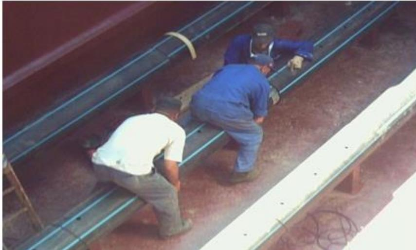
**Figure 4 :** réparation des ramificateurs intérieurs
