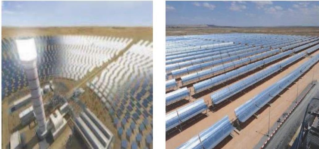
Figure I.10 : Énergie solaire thermique : tour solaire et parc solaire.
