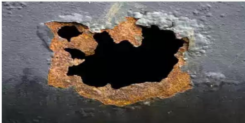
Figure II.2.2.La corrosion par piqure
