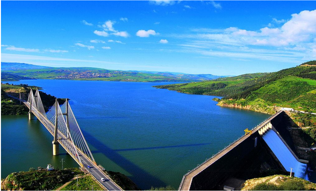
Figure (VI-1) : Vue du barrage de Beni Haroun
