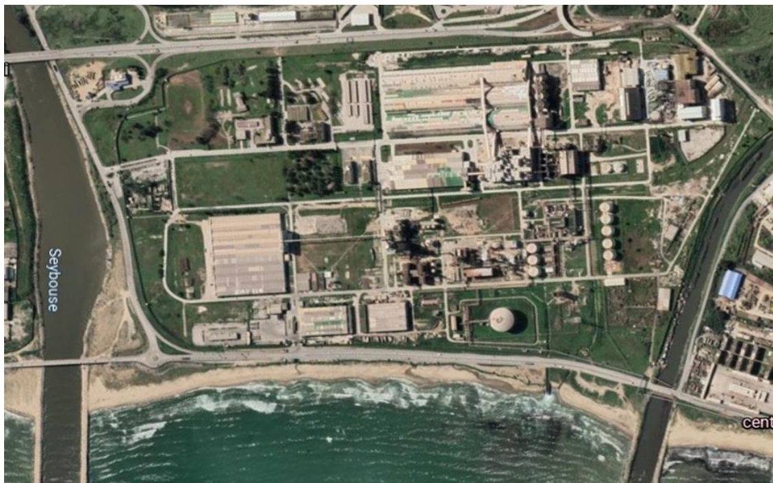
Figure. IV1. Localisation géographique de Fertial Annaba par Google Earth.
