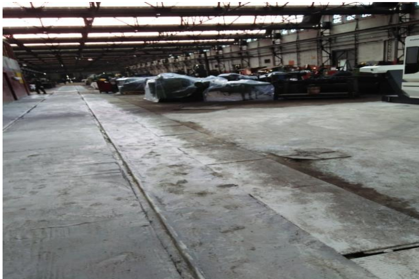
Fig. .I.1 Atelier mécanique
