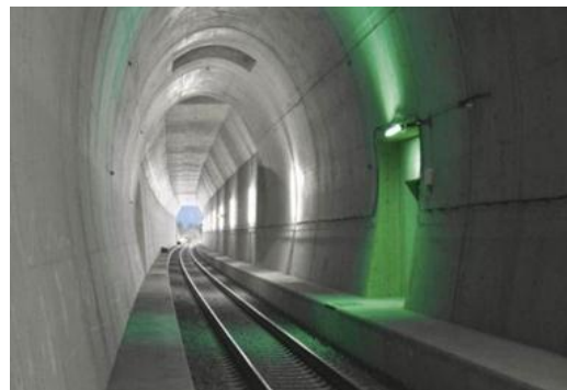
fig. :1.7les tunnels ferroviaires
