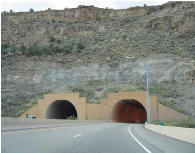
Figure 1. 3 Photo de tunnel routier sous montagne
