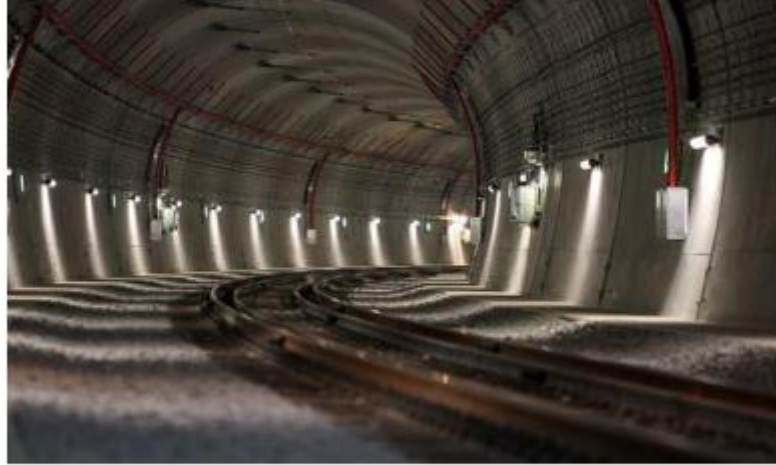
Figure 1. 4photo de tunnel de métro en zone urbaine
