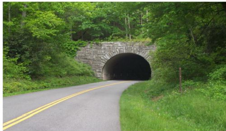
Figure 1. 5photo de Tunnel de Blue RidgeParkway traversant une forêt « kentucky, USA »
