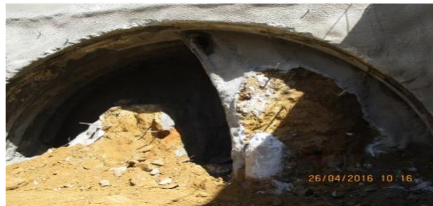
Fig. 1.12 : Excavation par la méthode de la section divisée dans le tunnel cadre du métro d'Alger
