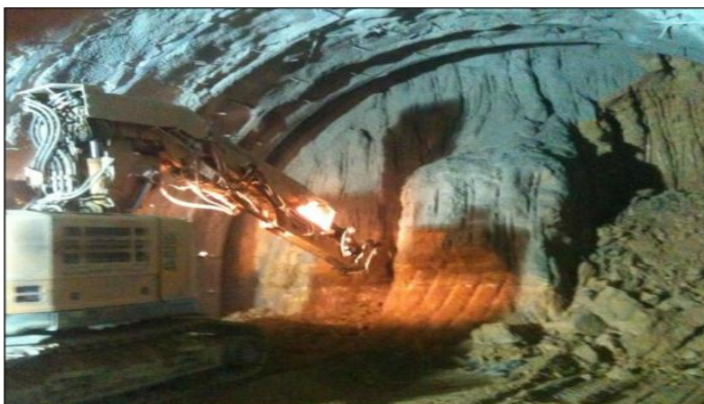
Fig. 1.11 : Creusement en demi-section
