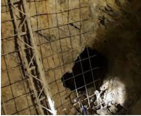
Fig1.19. : cintre réticulés
