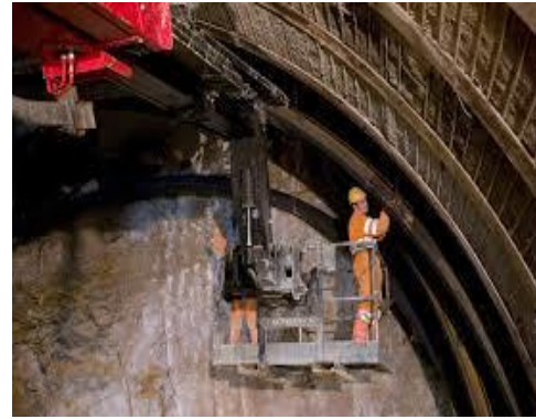
fig.1.20 : mise en place du cintre
