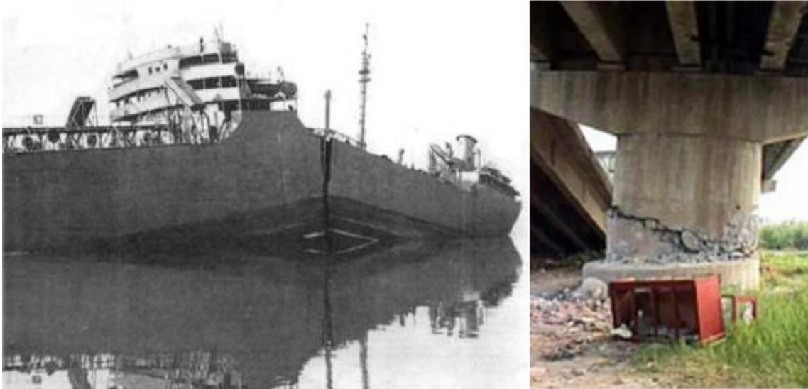
**Figure I.1 :** (a) Rupture fragile d'un liberty-ship (seconde guerre mondiale) au cours d'un hiver rigoureux, (b) Rupture d'un autopont lors d'un tremblement de terre.
