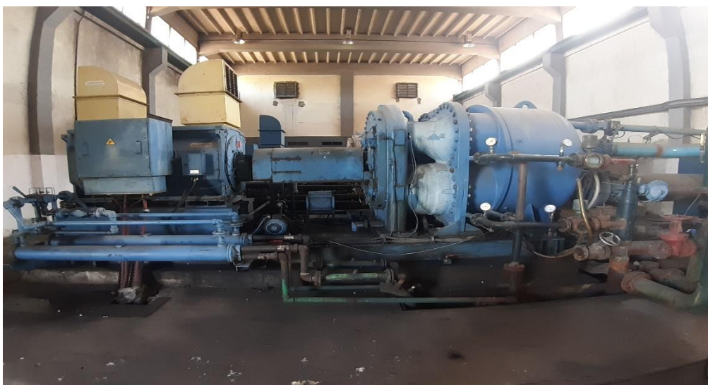
Figure III.1 : Le compresseur centrifuge centac [21].
