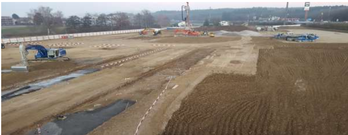
Figuré 1.5 les sols concernent par la technique des colonnes ballaster
