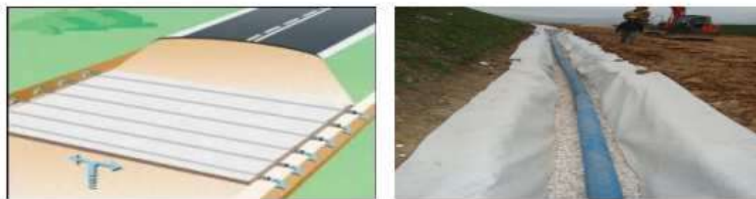
Figure 1.8. Utilisation des géotextiles pour le drainage.
