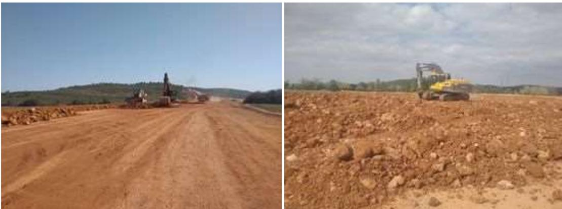
**Figure 1.1:** Préparation de Remblais sur sols compressibles
