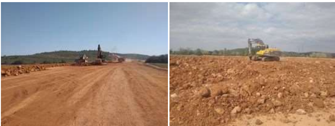
Figure 1.1: Préparation de Remblais sur sols compressibles
