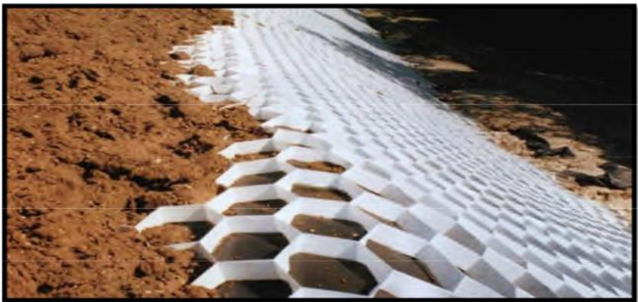
Figure I.31 - Renforcement par géotextiles (Boulfoul K.,2005)
