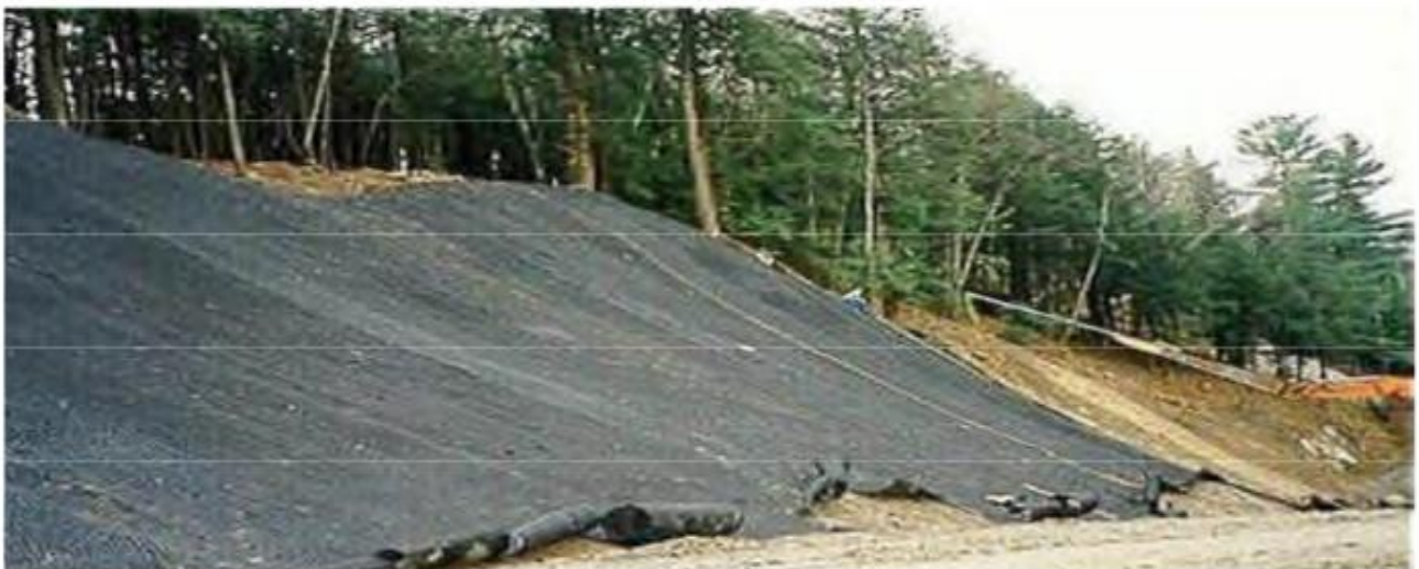
Figure I.32 - Renforcement par géogrilles.(Boulfoul K.,2005)
