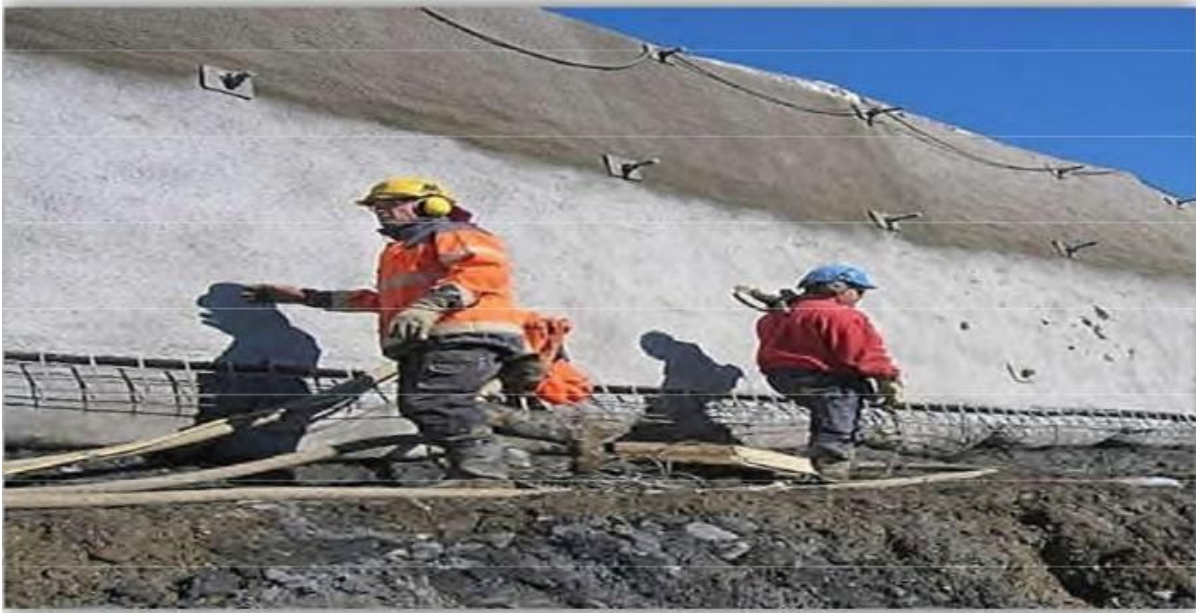
Figure I.34 - Renforcement par ancrage. (Cartier G.,1986)
