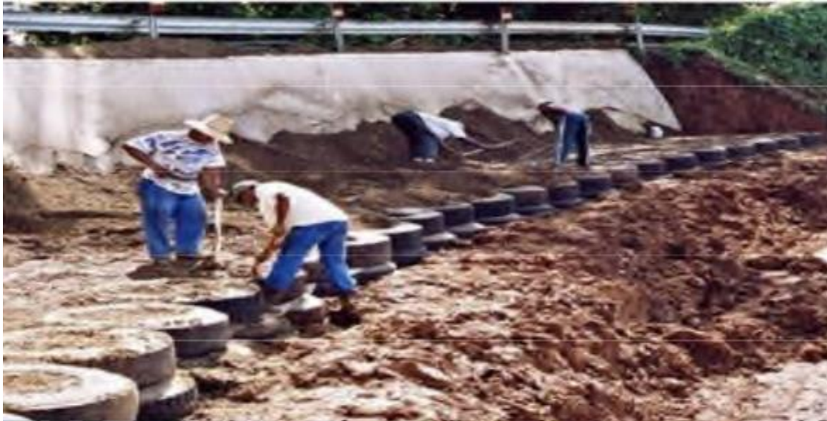
Figure I.33 - Renforcement par Pneusol. (Bedr S.,2008)
