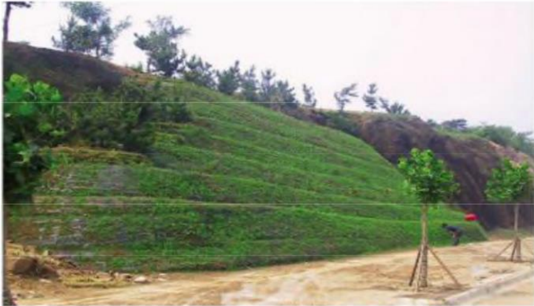
Figure I.30 – L’implantation des plantes dans un talus
